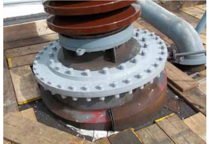
Belzona 5831 usado para sellar una fuga de aceite en un transformador
